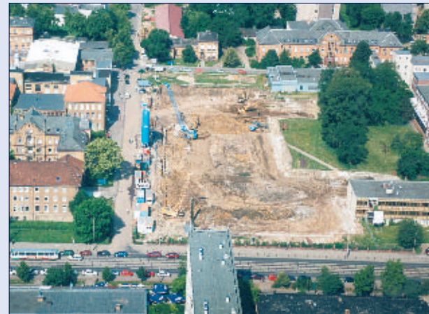
Baugrube für den ersten Bauabschnitt
