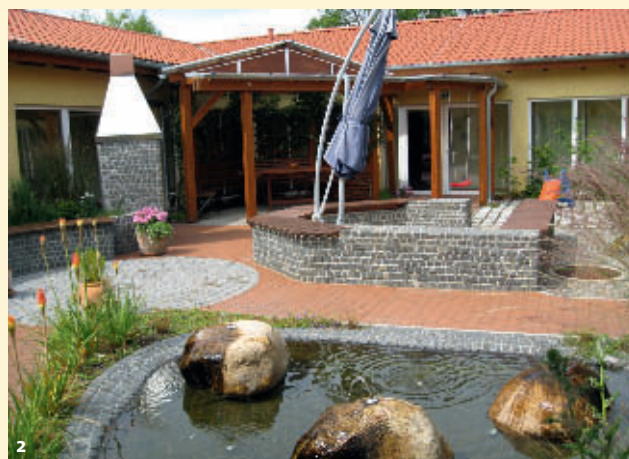
1 Zahlreiche Gratulanten waren der Einladung gefolgt 2 Ein Innenhof zum Wohlfühlen (Fotos: Förderkreis)
